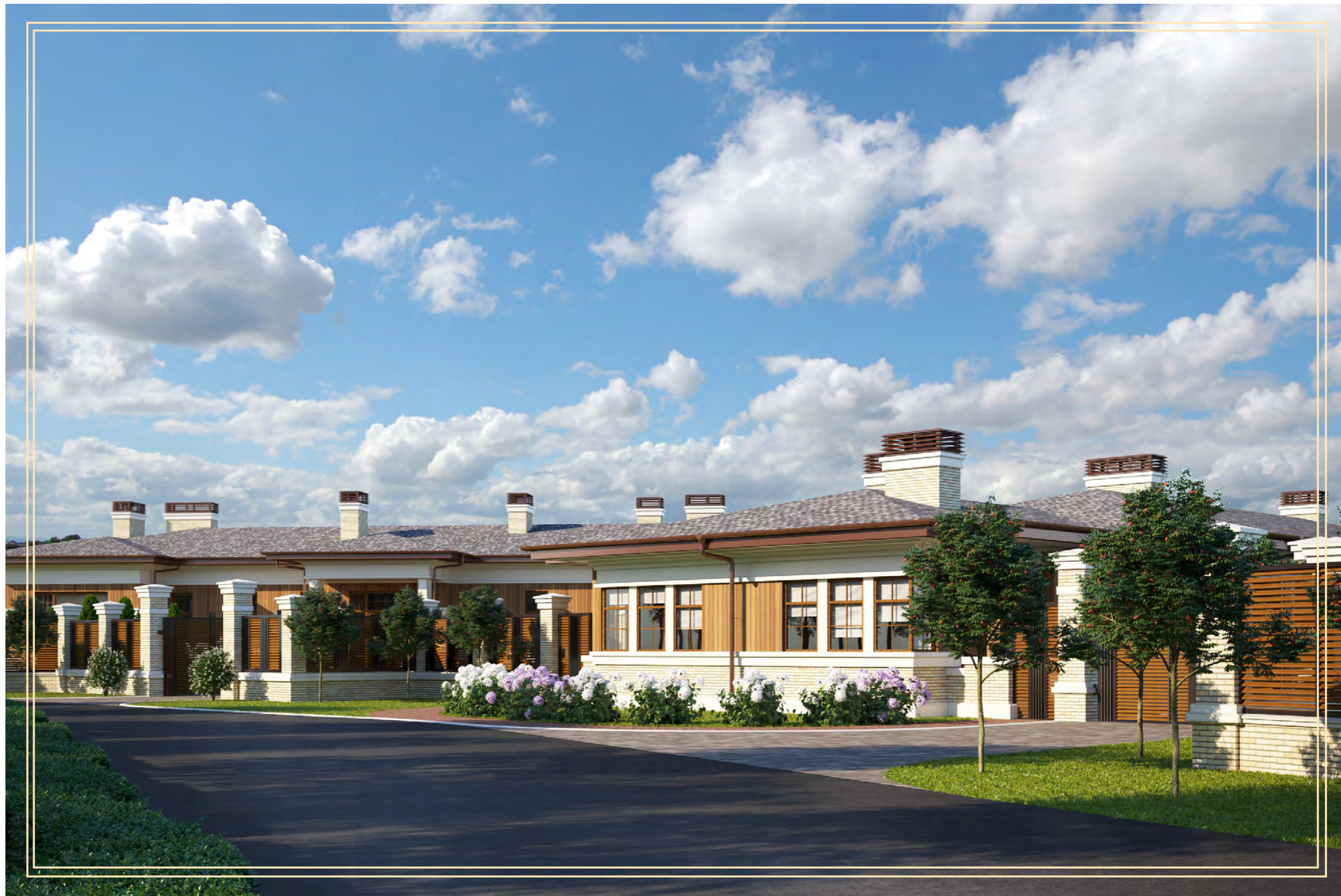
Общий вид на въезд с юга
